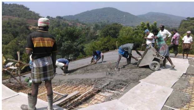
Unsere Schulzimmer erhalten das Dach.
