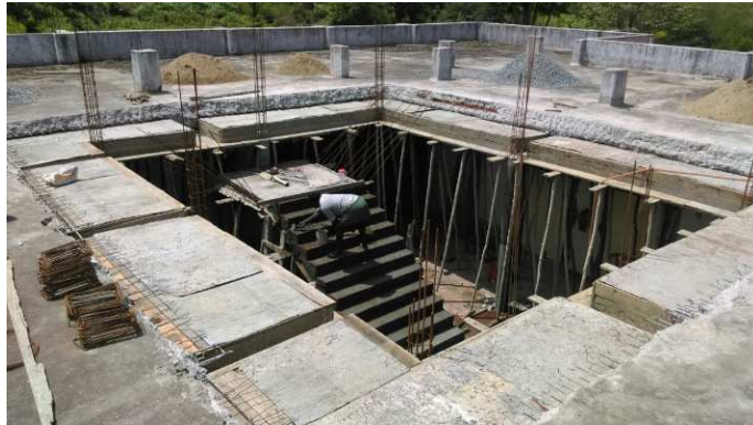
Als erstes entsteht die Treppe.
